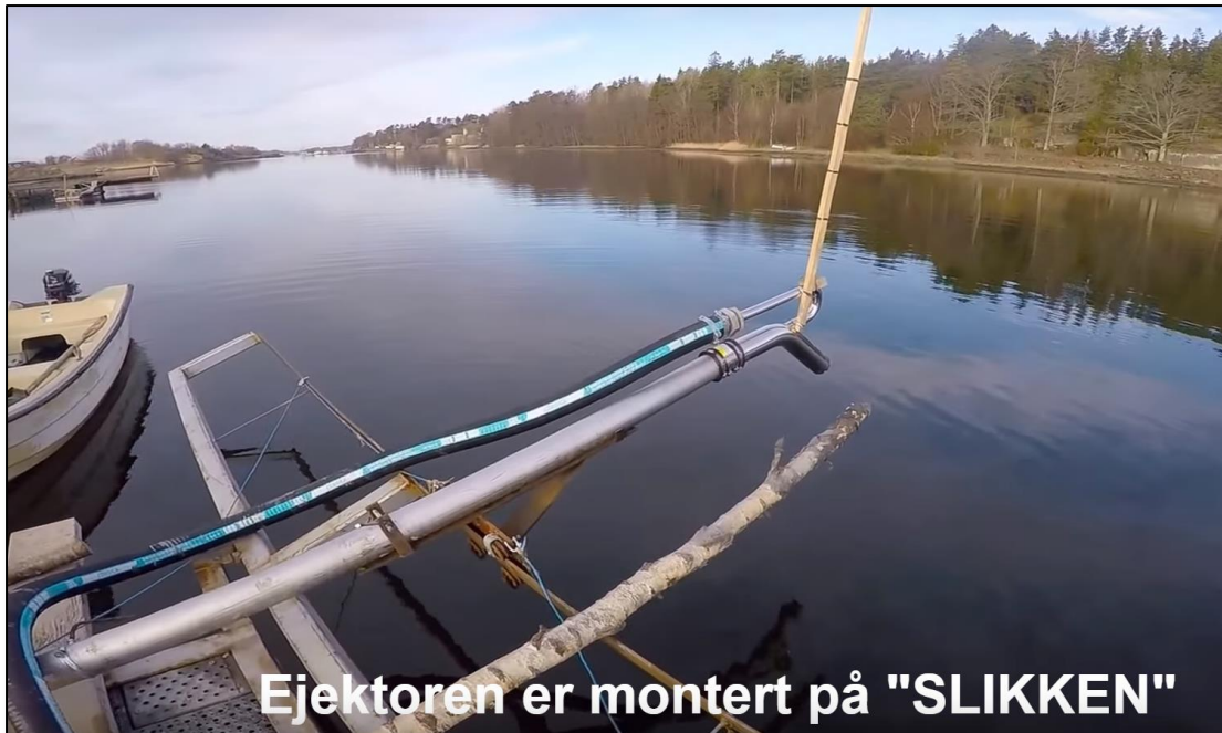
15.04.16: Ejektor montert på SLIKKEN
