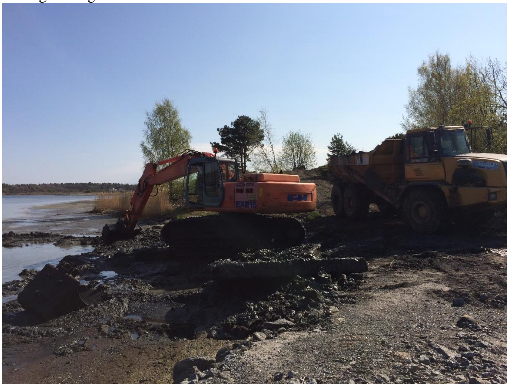
Forbedring av opptaksted
