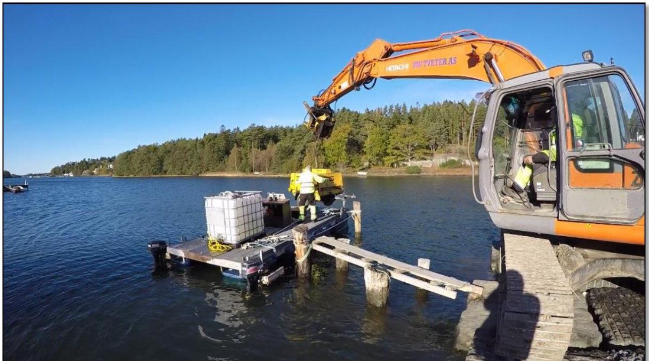
Bilde 10: Klargjøring av kompressor ombord på SLIKKEN, før luntinjisering.
