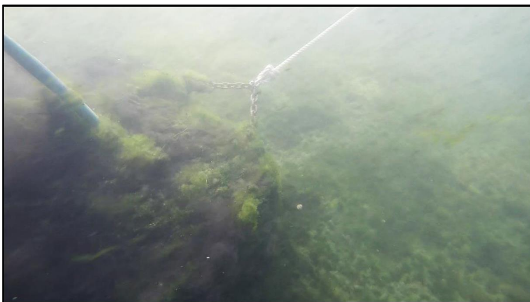
Bilde 15: Trekking av injiseringslede over bunnen, luft ikke påsatt.
