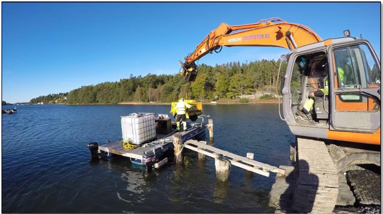
Figur 18: Klargjøring av kompressor ombord på SLIKKEN, før luntinjisering.
