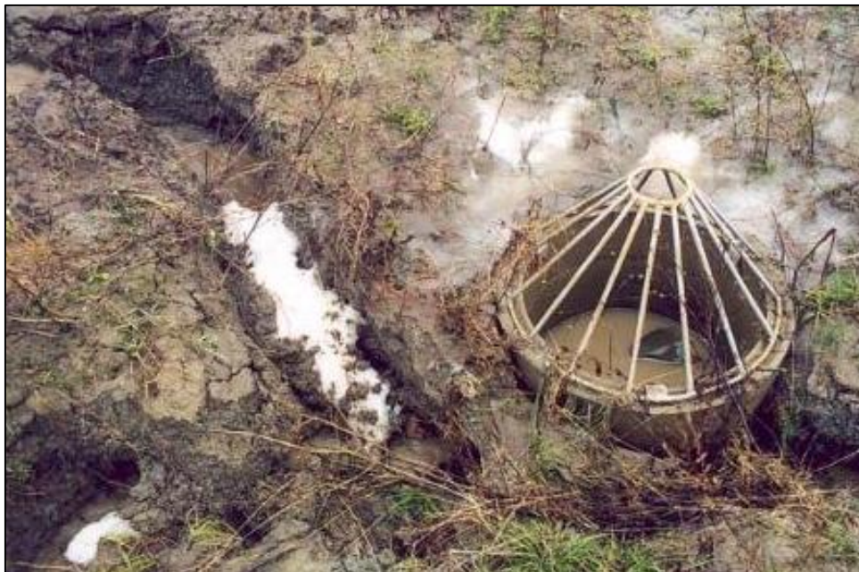
Figur 42: Erosjon rundt kum(Foto: Bioforsk).
